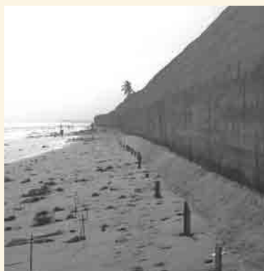
Mur de protection des cimetières de MBao
