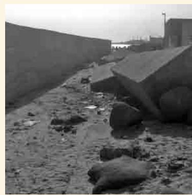
Mur de protection du quartier de Diokoul de Rufisque
