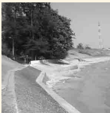
Mur de protection côtière au niveau de la Résidence Présidentielle de Popenguine
